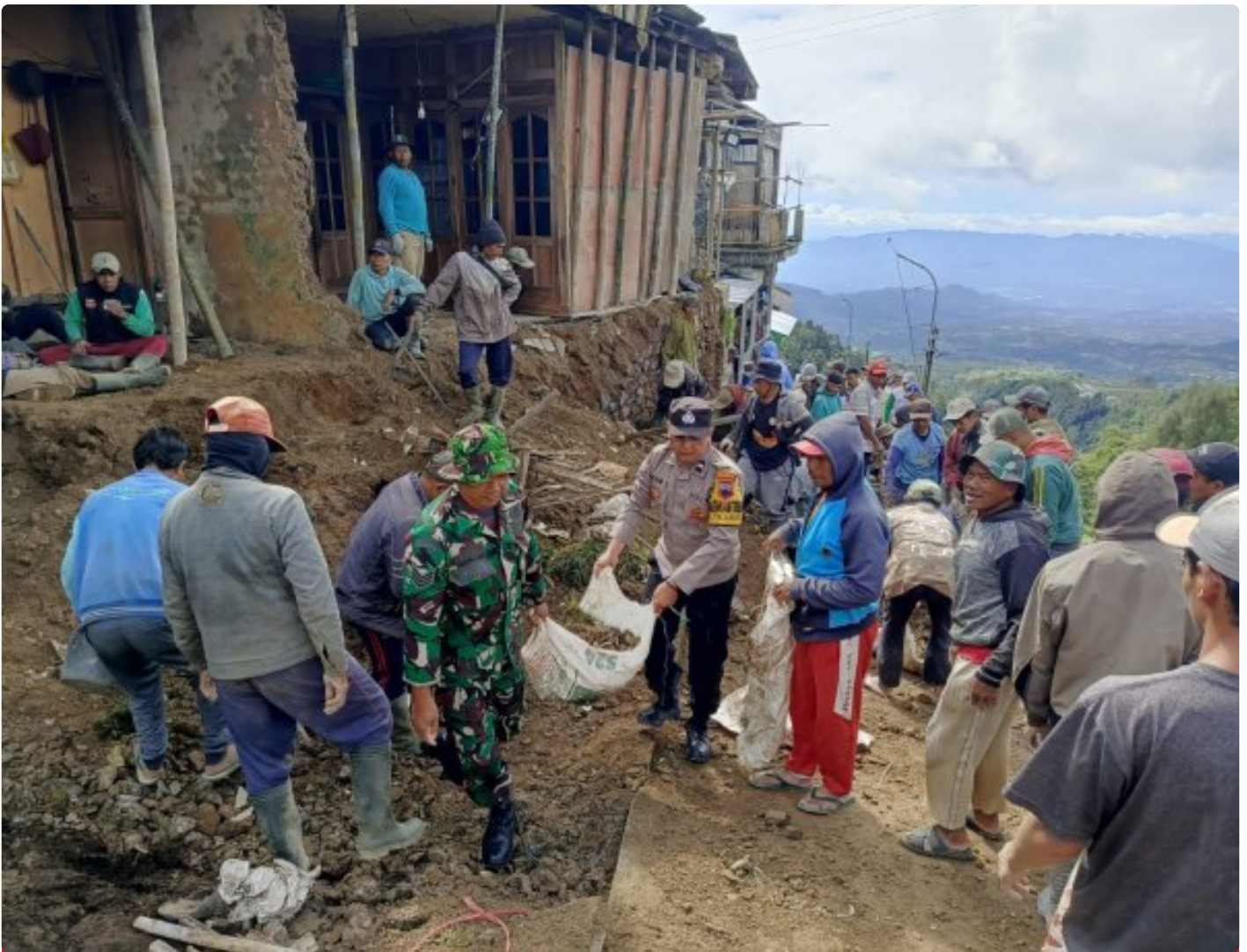
(Foto Dokumen) : Gotong royong pembersihan material longsor
